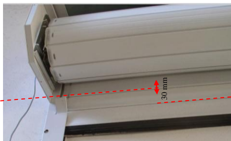
Réglage fin de course en Position Haute
