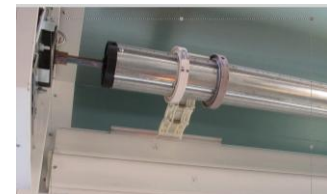
Réglage fin de course en Position Basse
