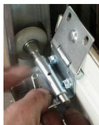
Mise en place de la deuxième partie du porte roulette résidentiel latéral avec une roulette
