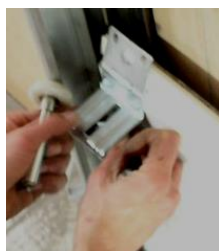
Mise en place de la vis
