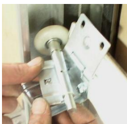
Mise en place de la deuxième partie du porte roulette résidentiel latéral avec une roulette
