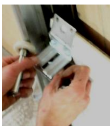
Mise en place de la vis
