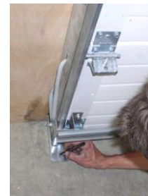
Marquer l'emplacement des perçages sur les pieds de la porte
