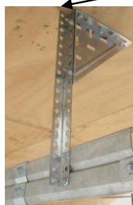
Equerre côté intérieur du rail
