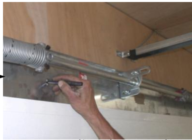
Marquer l'emplacement des perçages sur la traverse haute de la porte
