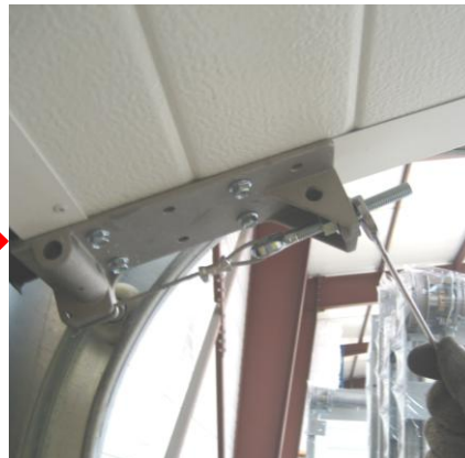
Serrer la vis de réglage de la plaque de base
