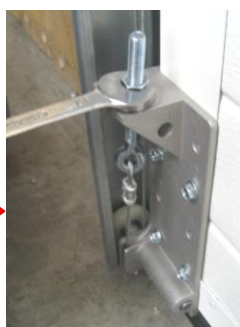
Serrer la vis de réglage de la plaque de base
