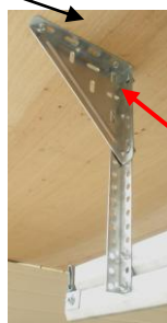
Equerre côté extérieur du rail
